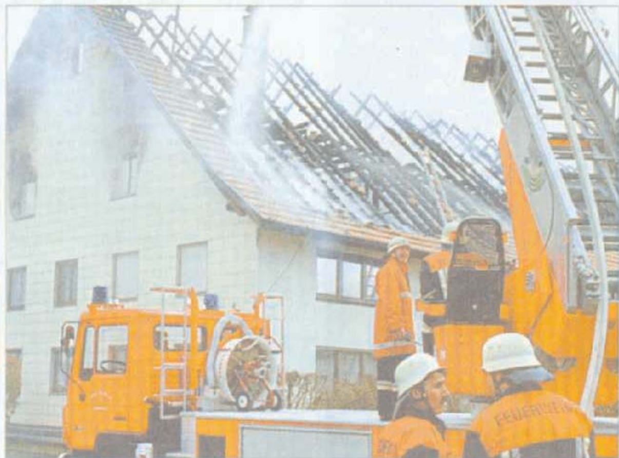
Nicht mehr zu retten war der Dachstuhl eines alten Bauernhauses an der Benninger Lindenstraße. Trotz massiven Einsatzes der Feuerwehr brannte er aus. Foto: Hefele-Beitlich
